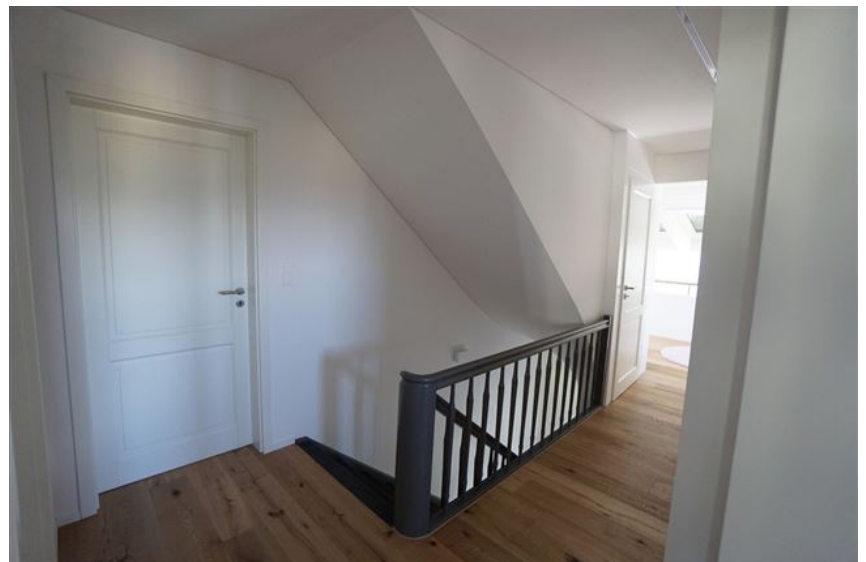
Vorher Korridor 1.OG
